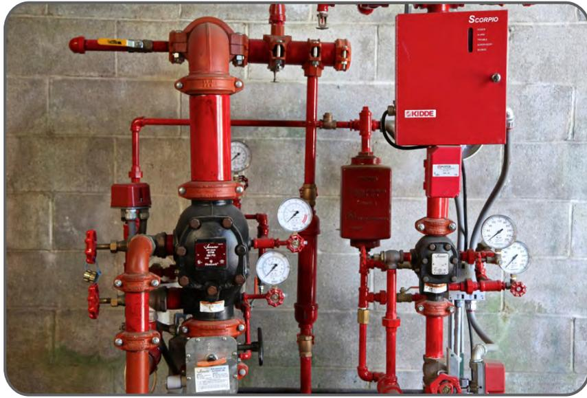
الشكل (٤١): صاعد نظام المرشحات المؤخر - المسبق (Pre-Action Riser Sprinkler System).
